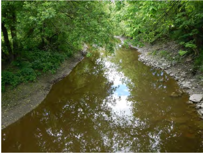
Figure 18: Bank erosion on QM.05.
