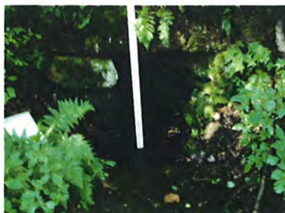
File Name : M06A railroad culvert 003.jpg
